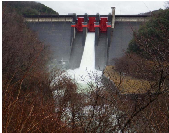
写真は、約30m 3 /s放流時の様子（平成27年3月19日撮影）
